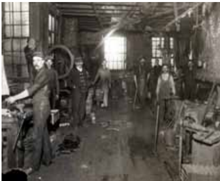
Alrededor de 1910 - Polk Street Plant - Chicago, Illinois
